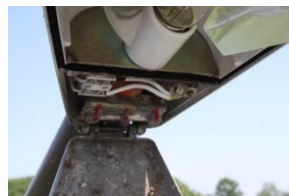
灯具先端のナトリウム灯を開く
