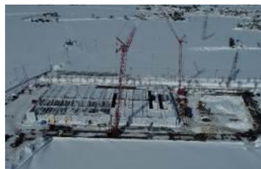
【建築中の様子(ドローン撮影)】
